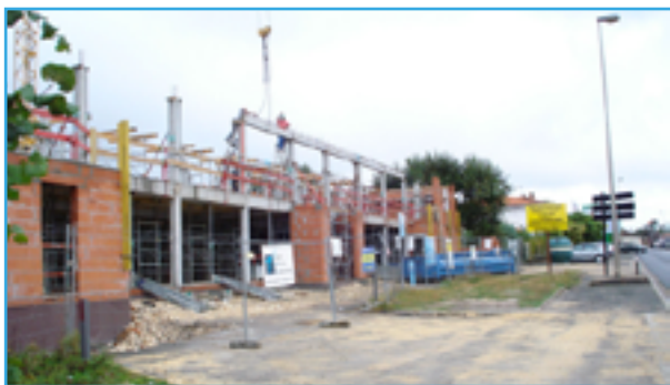
Construction du Centre de Périgueux (2009)
