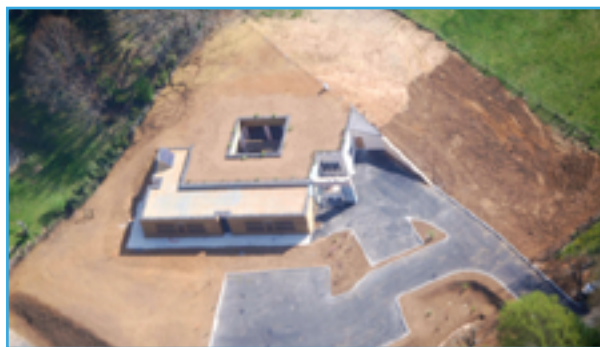
Construction Centre de Sarlat (2009)
